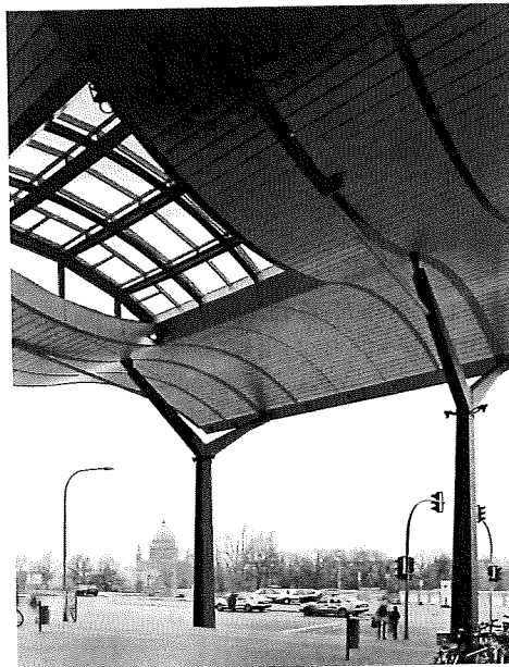
Bandbeschichtete Alupaneele an der Überdachung des Eingangsbereichs Bahnhof Potsdam
